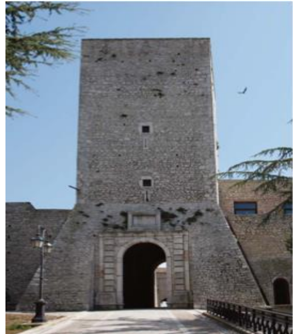
Fig.5 -Casalbore, torre sveva.
