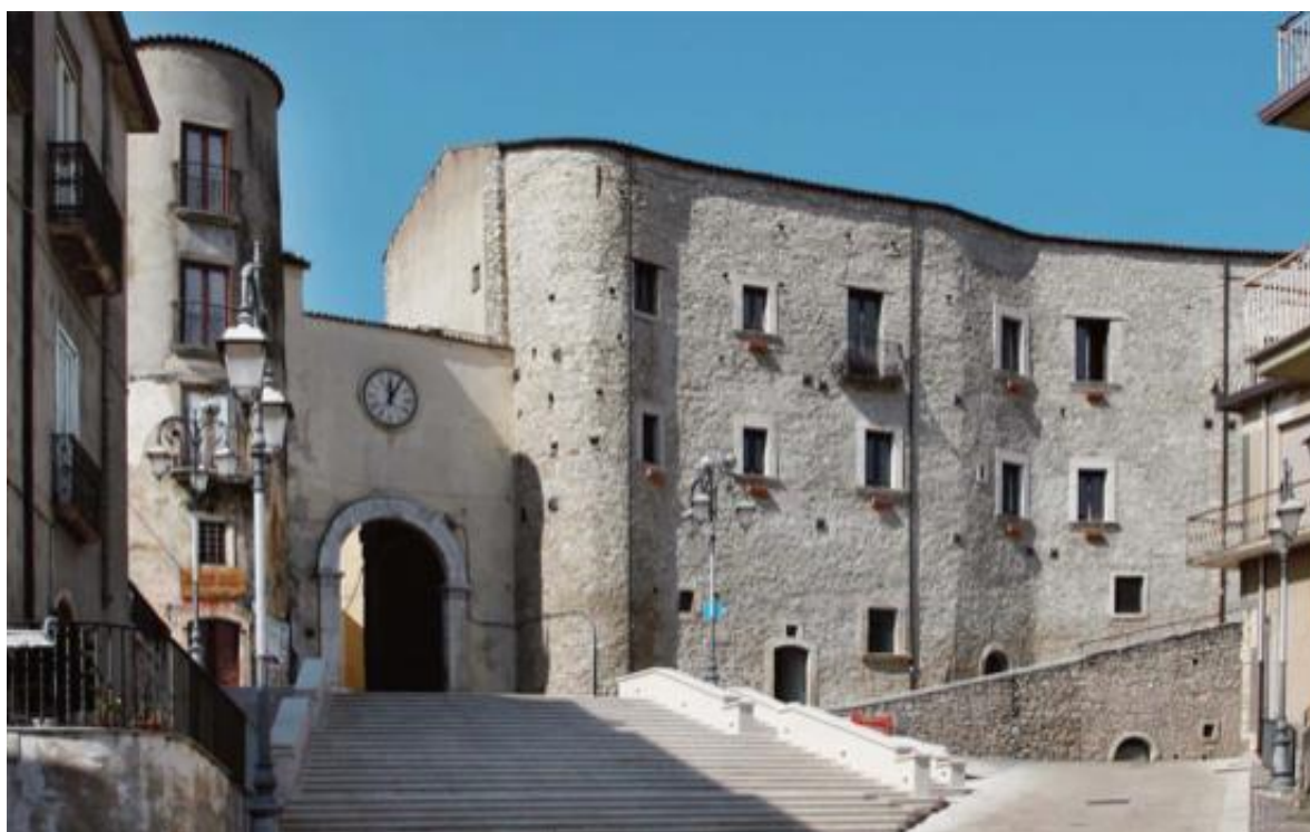
Taurasi, castello, porta maggiore e prospetto rinascimentale su via Roma.
