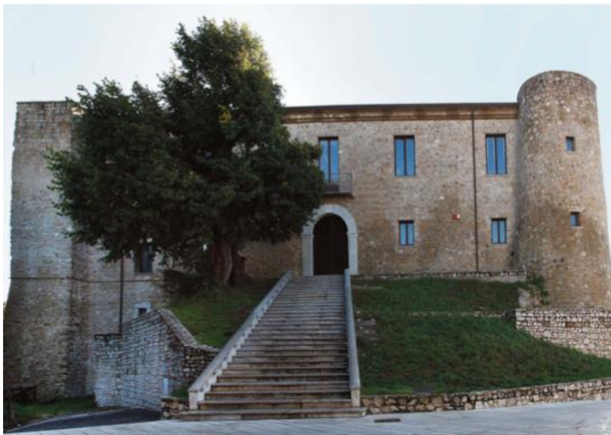
Manocalzati, Castello di San Barbato, prospetto principale Ovest.
