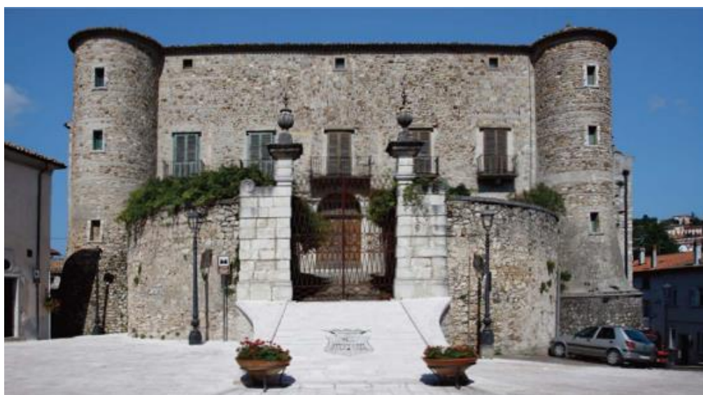
Zungoli, castello, prospetto principale.
